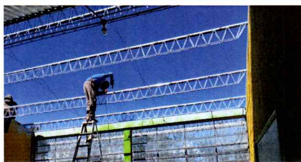
Foto 2: Realización de mantenimiento de estructura de soporte joists
