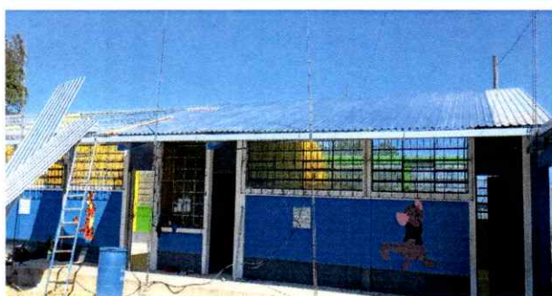
Foto1: Realización de cambio de cubierta
