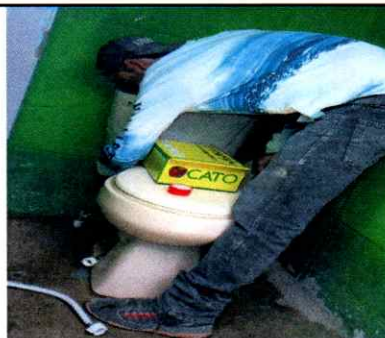
Foto 6: Cambio de accesorios de los servicios sanitarios
