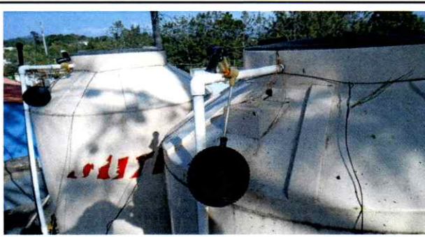
Foto 4: cambio de accesorio de depósito de agua
